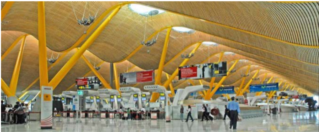
Figura 2: Cubierta de la terminal T4 del aeropuerto Adolfo Suárez Madrid-Barajas.
