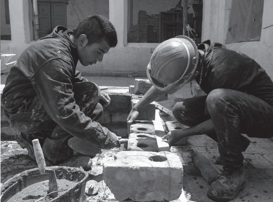
**Imagen 9:** Construcción de muro en bloque de tierra comprimido, Claustro Santa Clara la Real, 2016
