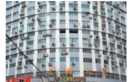
Figura 1. Aire acondicionado edificaciones. Fuente: Jaton Mallorca. (2017). Aire acondicionado contra calor [fotografía]. Recuperado el 06 11 2017. Sitio web. http://www.jatonmallorca.com/aire-acondicionado-contra-el-calor-pero-sin-molestar-a-los-vecinos/
