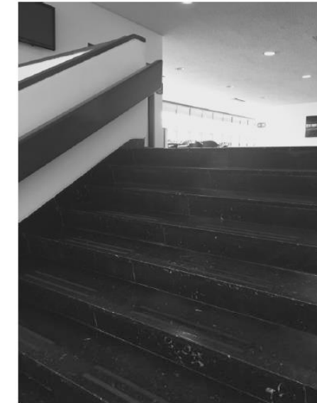
Biblioteca Luis Ángel Arango, 19 de octubre 2016: Escaleras de acceso principal, ©Mauricio Alvarado G.
