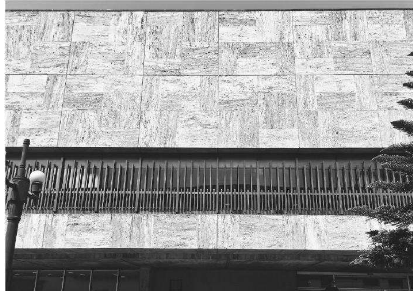
Biblioteca Luis Ángel Arango, 19 de octubre 2016: Fachada sobre calle 11, ©Mauricio Alvarado G.
