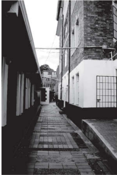
Foto 13. Separación entre edificación principal y volumen garaje . FOTO: A. Toro
