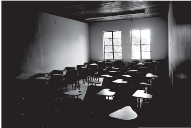
Foto 31. Cielo Raso original. FOTO: A. Toro
