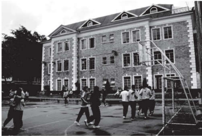
Foto 25. Fachada lateral norte . FOTO: A. Toro Las 4 fachadas están integradas por una cornisa y por un zócalo en concreto. En la fachada oriental, este zócalo se transforma en materia.
