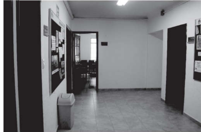
Foto 30. Acabado de pisos. FOTO: A. Toro
