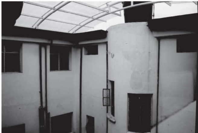
Foto 32. Acabado de Muros. FOTO: A. Toro
