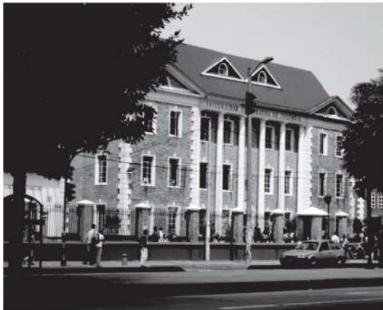
Foto 26. Edificación en los años 90 (Nótese la cubierta original) FUENTE: Universidad Cooperativa.
