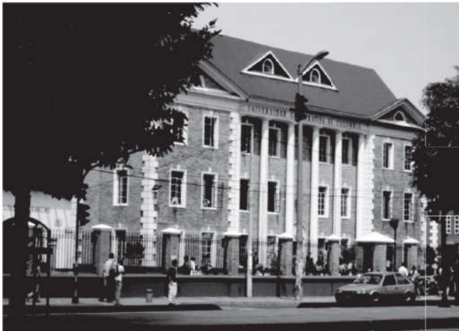
Foto 24. Fachada principal . FUENTE: Universidad Cooperativa
