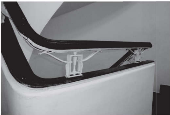
Foto 23. Baranda escalera principal . FOTO: A. Toro
