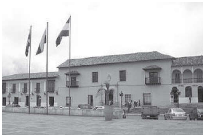
Imagen 7. Fachada Casa del Fundador. Tunja - Boyacá.
