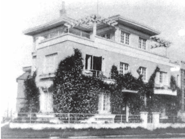
Foto 11. Casa donde funcionó el Colegio Santa Clara entre 1939 y 1946. Carrera 18 calle 37
