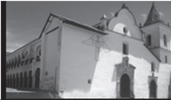
DESCRIPCIÓN DE LAS PATOLOGÍAS PRESENTES
