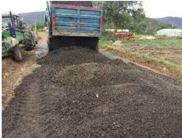
Figura 8. Extendida material de fresado.
