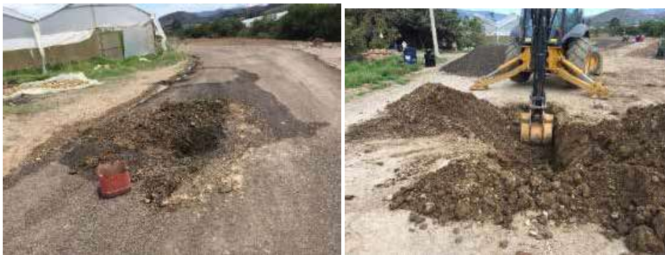
FIGURA 4. REPARACIÓN DE REDES HIDRÁULICAS Y PUNTOS DE GAS NATURAL
