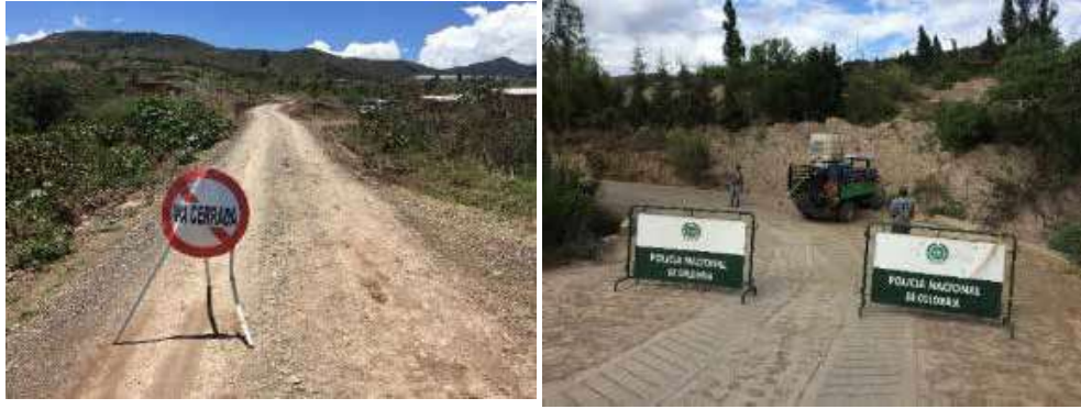
Figura 7. Señalización presente en la obra.
