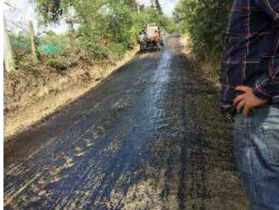
Figura 11. Imprimación con emulsión asfáltica para sellado.
