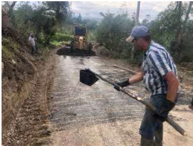
Figura 10. Imprimación con emulsión asfáltica entre capas
