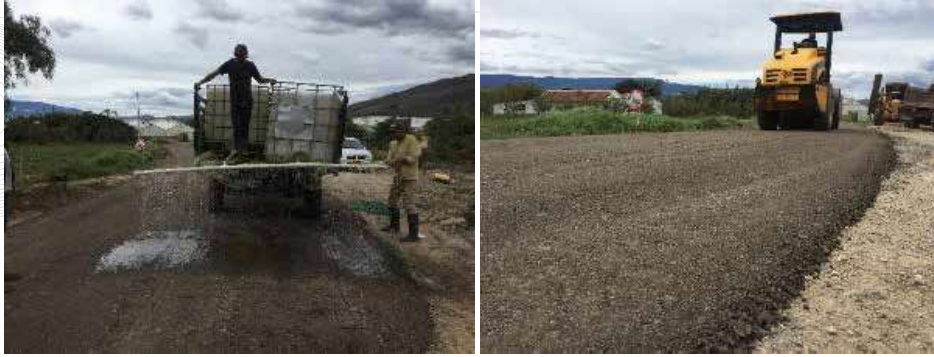
Figura 9. Humectación y compactación del material de fresado.
