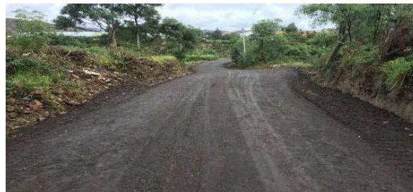
Figura 12. Mejoramiento de la vía en estudio.
