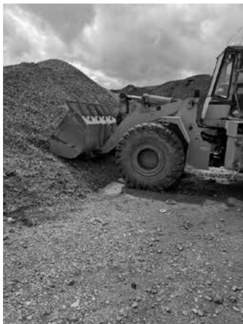
Figura 1. Acopio empresa Csa constructores S.A (Base granular).
