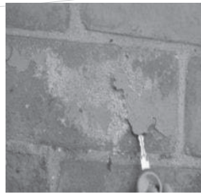
FIGURA 9. EFLORESCENCIAS DE SODIO. Fuente. Recuperado de Mejía, S. Origen de las Eflorescencias. 2013. Disponible en línea: https://es.slideshare.net/SergioPap/origen-de-las-eflorescencias-octubre-16-2013 .
