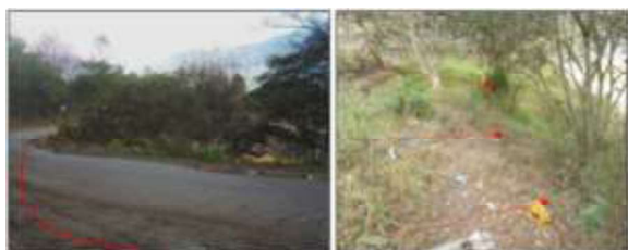
Figura 7. Vista general del movimiento del material. Fuente: Servicios de ingeniería Limitada
