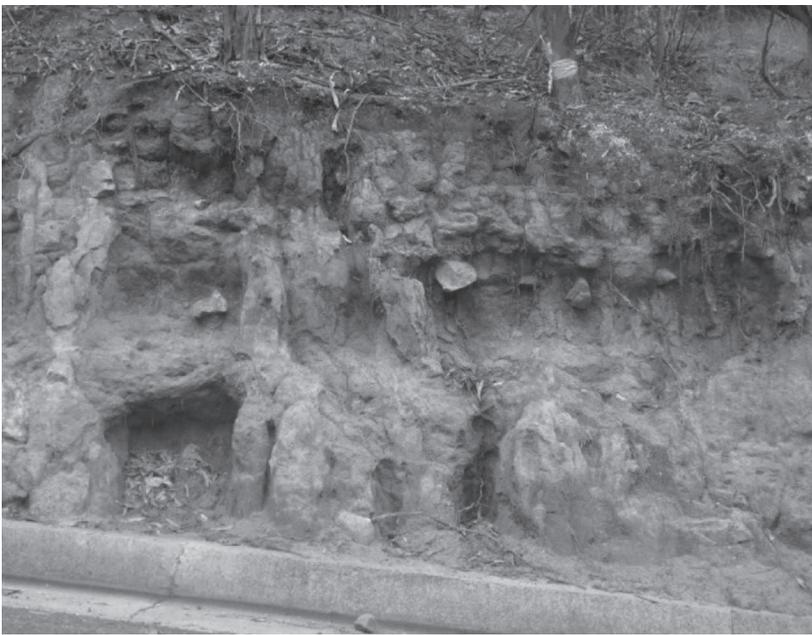
Figura 2. Erosión hídrica en talud vía Tunja-Motavita
