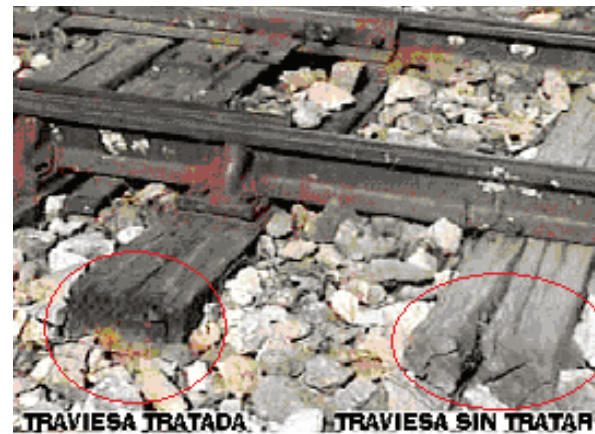
Figura 9. Traviesa tratada Vs. Traviesa sin tratar
