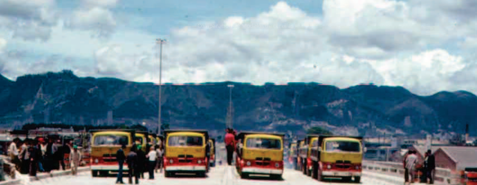
FOTOGRAFÍA 2. PRUEBA DE CARGA.
