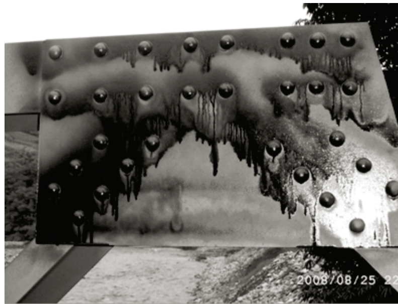
FIGURA 1. APLICACIÓN DE LA TINTA REVELADORA DE FISURAS EN EL METAL. Fuente: Autora del proyecto
