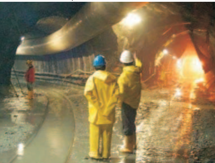
Fig. 4. Vista interior del túnel piloto, tomado de [4]
