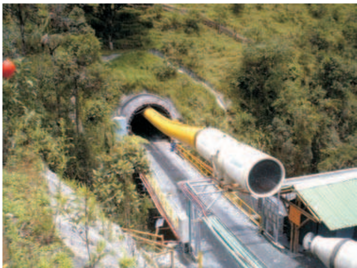
Fig. 6. Portal entrada túnel piloto, tomado de [4]
