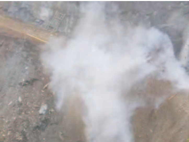
Fig. 11. Explosión controlada para la excavación túnel piloto, Tomado de [4]
