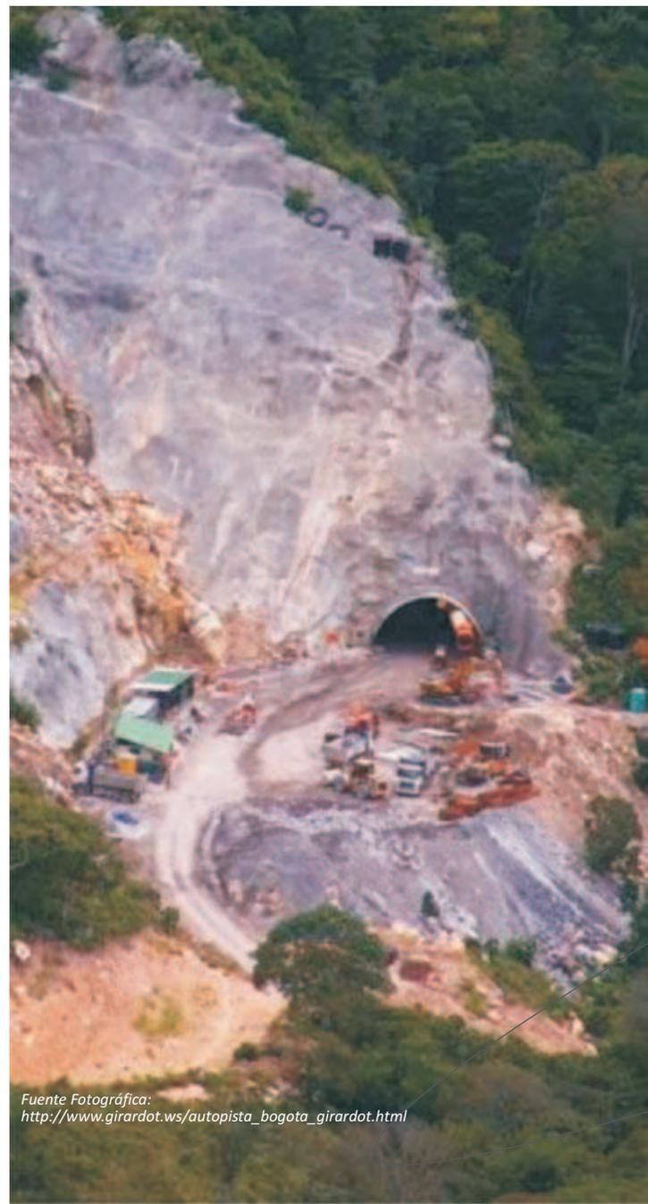
Los pasos que se efectuaron para la construcción fueron: se inició con la perforación para la colocación de explosivos. Segundo: se ubicaron los explosivos de manera circular del túnel. Como se observa en la figura 7, se comienzan a ubicar los arcos falsos salidos del orificio del túnel, los cuales se encargan de que los fragmentos del talud reforzado con concreto, no caigan o se desmoronen, que cumplan con el objetivo de servir como un piso falso.
