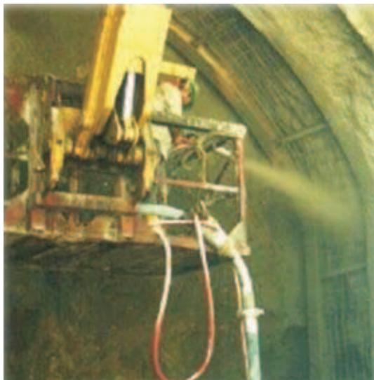
Fig.8. Cubrimiento de arcos con Concreto Lanzado. Tomada de [23].
