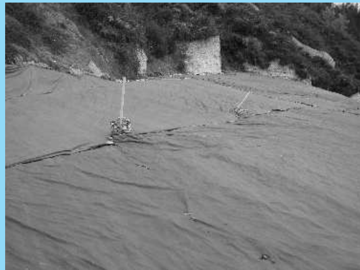
Figura 10. Celda para la disposición final de residuos sólidos. Autor
