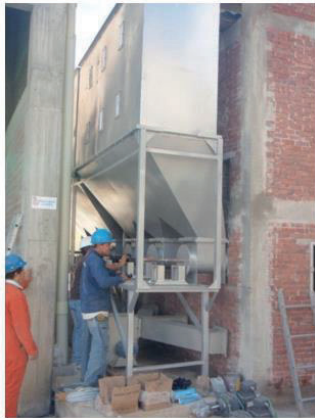
Figura 6. Transmisión de potencia de los tornillos sinfines.
