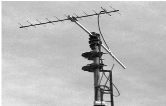
Figura 4. Conexión de antenas al rotor G-5500
